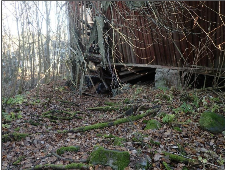
Länsihaaraa. Sortunutta juoksuhautaa ulkorakennuksen länsipuolella. Rakennuksen pohjoispää on juoksuhaudan päällä.
