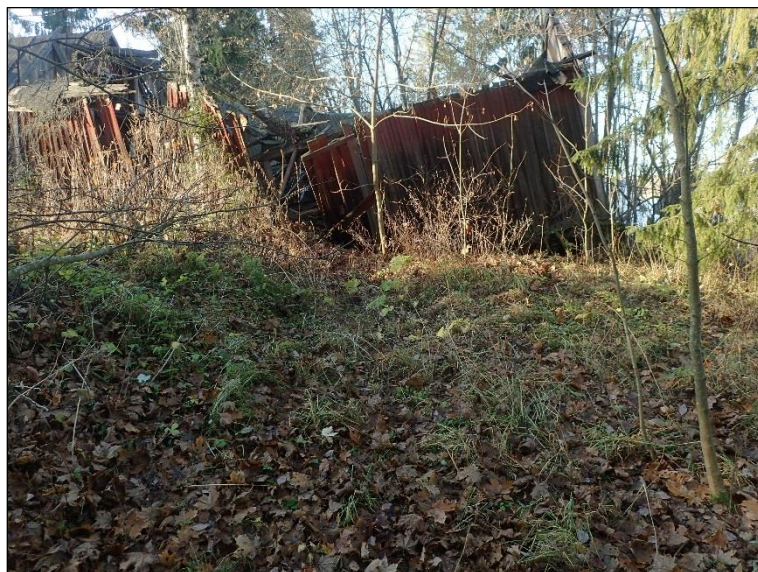
Hyvin sortunutta juoksuhaudaa ulkorakennuksen itäpuolella.
